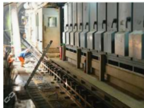
盾构 整体 滚轮 过站
