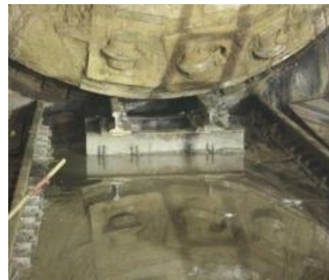
过站轮轨及盾体防磕头装置示意图
