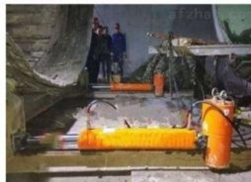
盾构 整体 常规 过站
