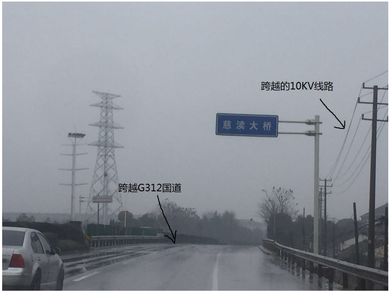
现场实物照片
