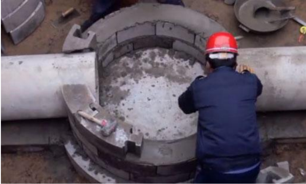
图 5.2.5 管道连接安装
