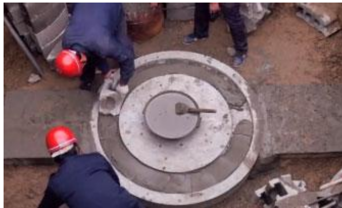
图 5.2.4-1 预制底座凹槽砂浆摊铺
