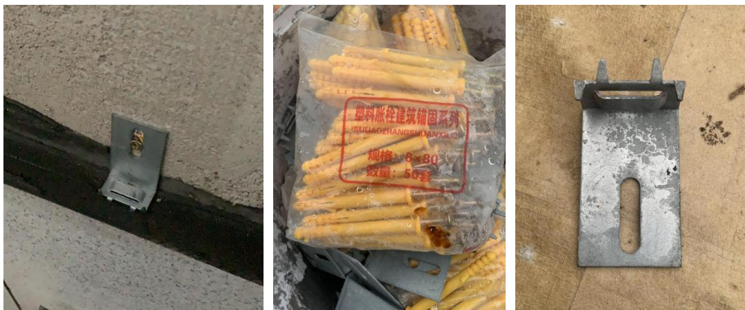
图 5.5.3-1 锚固件的安装 图 5.5.3-2 锚固件套件 图 5.5.3-3 角码
