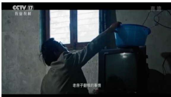
图 2-7 梁学军房子漏雨
