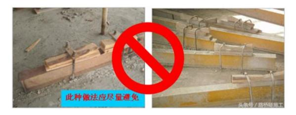
尽量防止在钢梁与压板之间用木方加固,严禁使用"几字"预埋抱箍和木楔加固。
