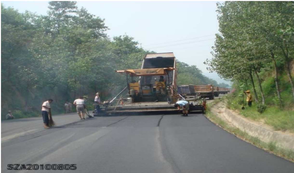
摊铺机熨平板出现段差时的摊铺效果
