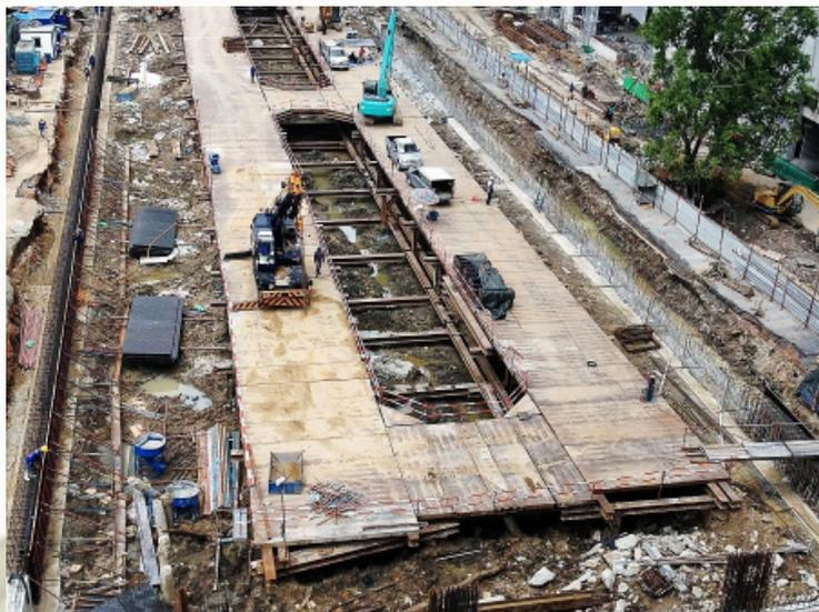
地下综合管廊是一种将多种管线集中敷设在同一地下空间，并留有供检修人员行走通道的隧道结构。
