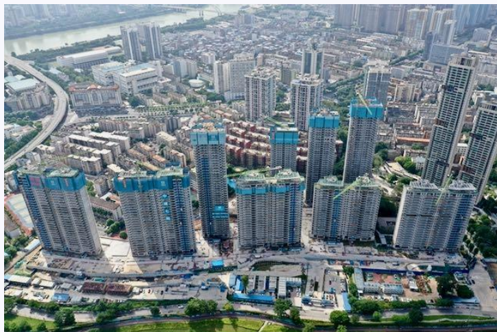
位於中國南寧住宅項目工程
