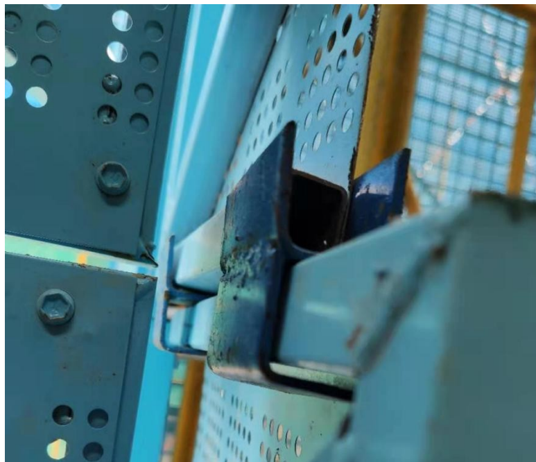
图 6.3-12 连接件和钢板网连接效果图
