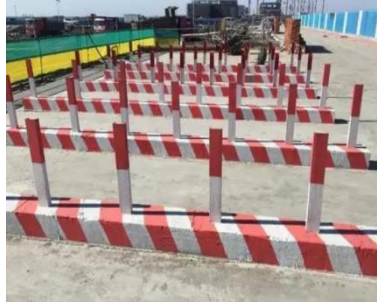
图 3.2 混凝土加槽钢组合条墩
