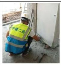
①地缝堵塞满 ALC 板 底部预拌砂浆
