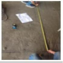
③对照图纸复核线 、 复核主体
