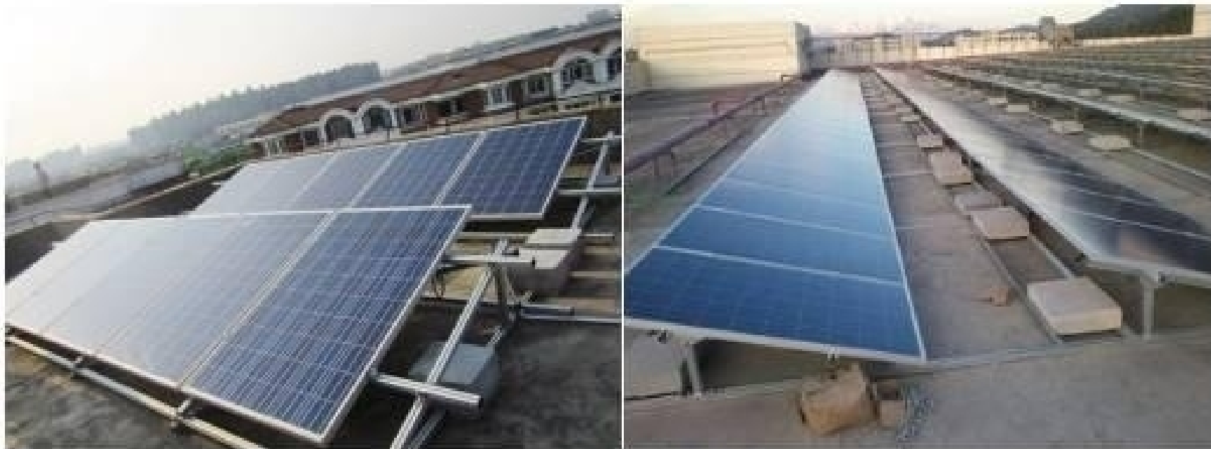
平顶屋面混凝土压载支架
