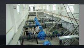
技术供水系统还承担着为水电站调节系统提供水源的任务,确保调节系统的正常运行,保障水电站的安全和稳定。
