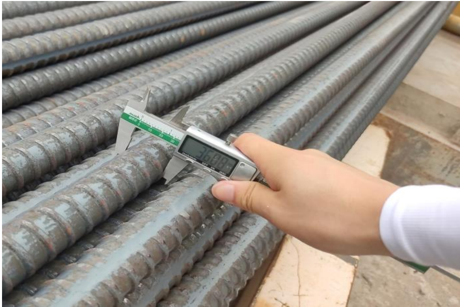
5.2.2-5 锚杆堆放验收图
