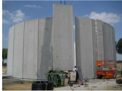
发酵罐的拼装施工
