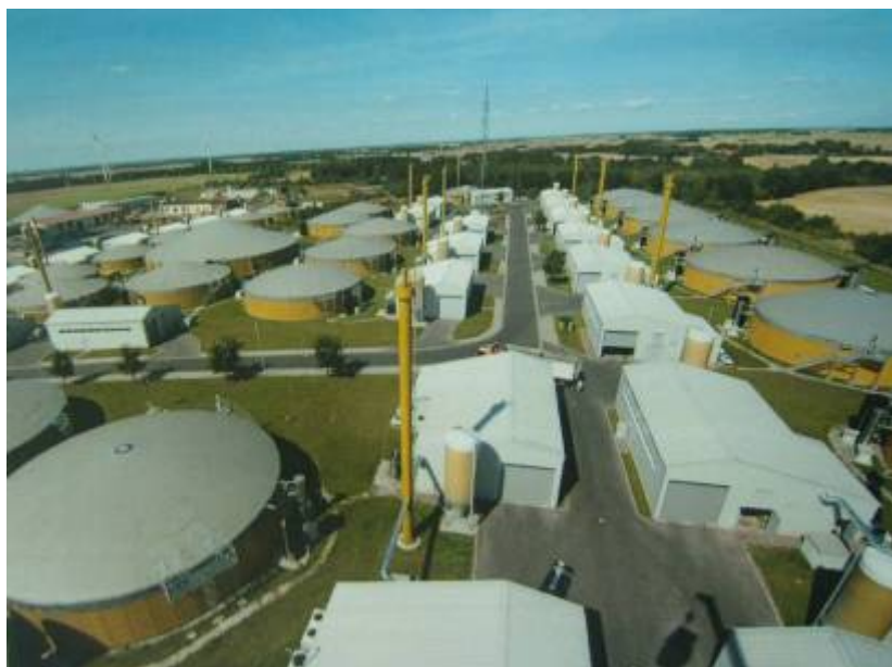
图 3-2 CSTR 产气储气一体化工艺
