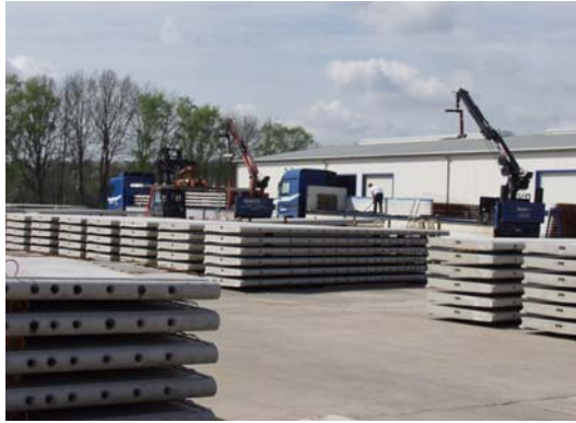
预制钢筋混凝土板生产
