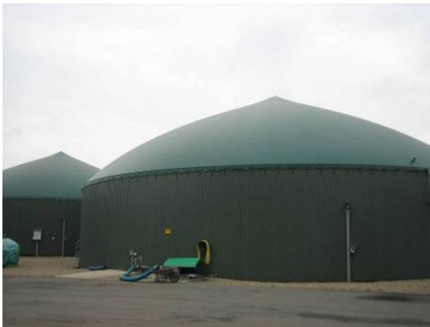
图 3-1 CSTR 产气储气一体化工艺
