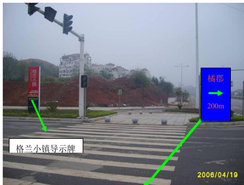
万家丽路与芙蓉路交汇处立导示牌
