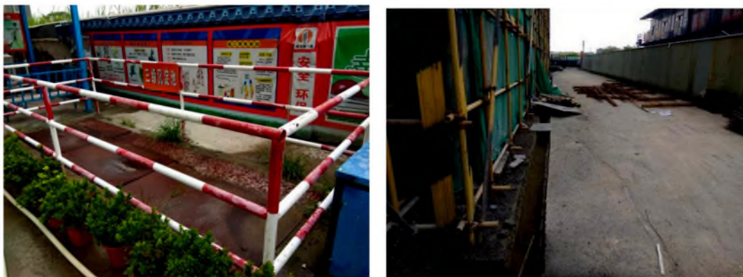
图 4-2 项目区内排水沟和沉沙池
