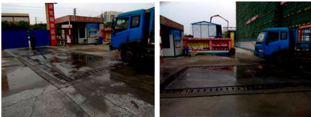
图 4-1 出入口洗车池
